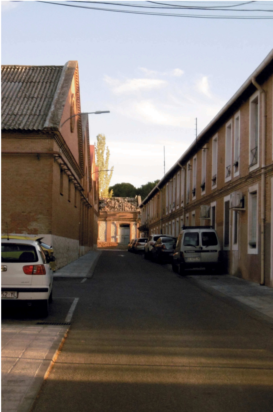
Vivienda al fondo con Cubierta en ruina
