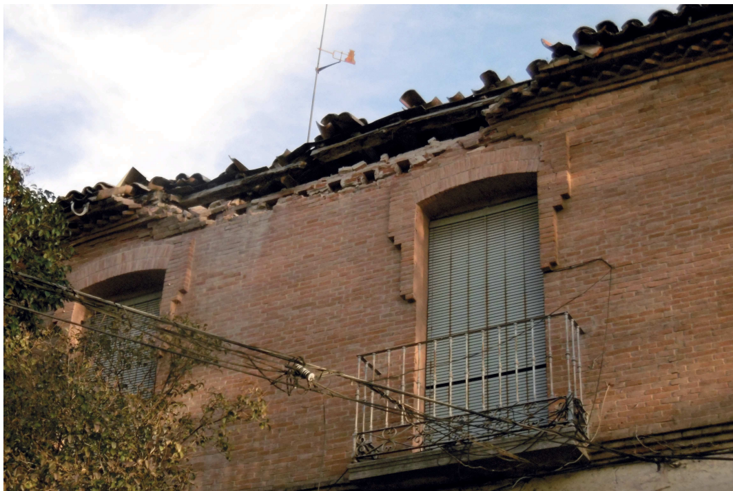
Cubierta en ruinas y parte ya hundida en avanzado estado de deterioro.
