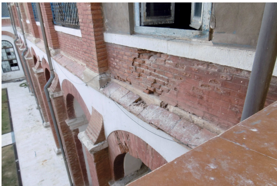
Meteorización y deterioro del Ladrillo
