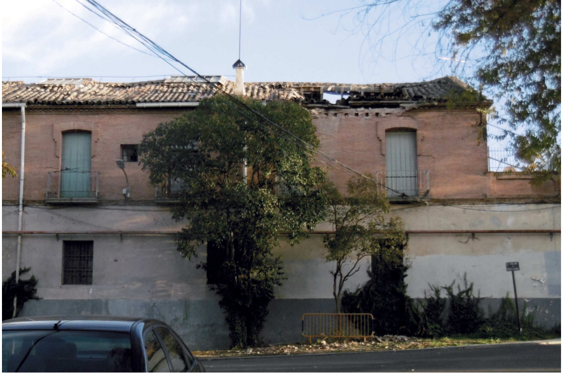
Cubierta en ruinas y parte ya hundida en avanzado estado de deterioro.
